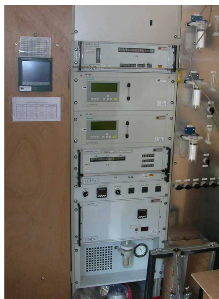
Photos 1 et 2 : Exemple de camionnette laboratoire et de baie d'analyseurs de gaz IRH Ingénieur Conseil
